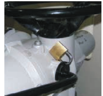
Kuva 2 IQ-hand-auto-vipu kiinni munalukolla
