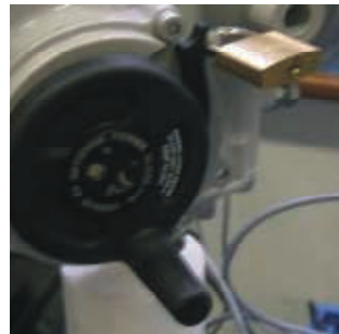
Kuva 1 IQT-hand-auto-vipu kiinni munalukolla
