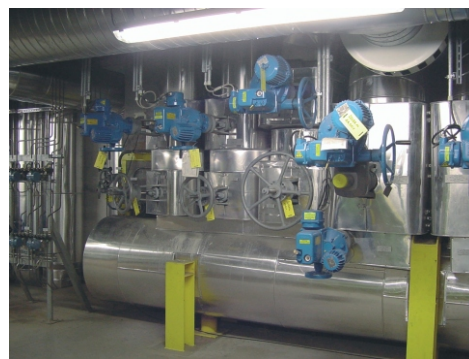
DREHMO®电动执行器应用在某化工厂
