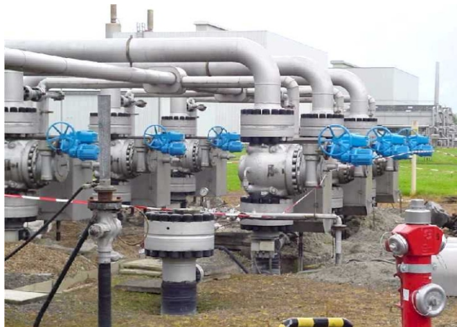
DREHMO®电动执行器应用在天然气管道上
