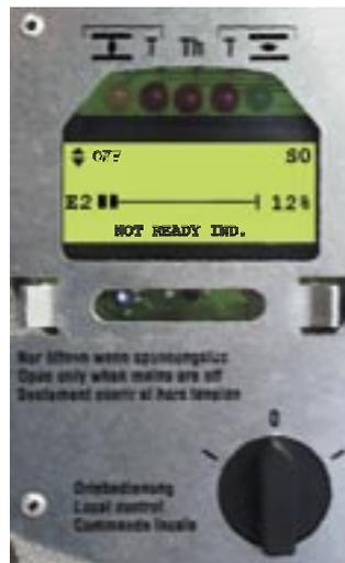
现场控制单元上的选位开关 (图 P2) 处于 (0) 位置。
